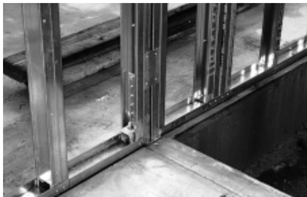
写真3 基礎と土台の接合状況
