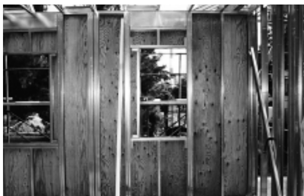
写真4 壁組の組立状況
