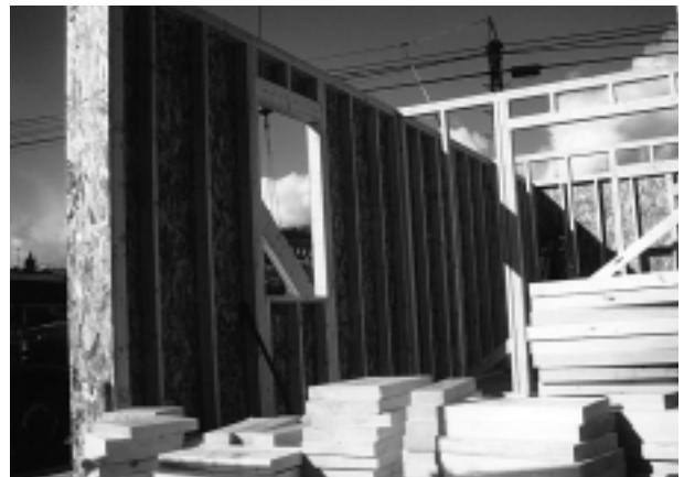
写真1 一般的な枠組壁工法
