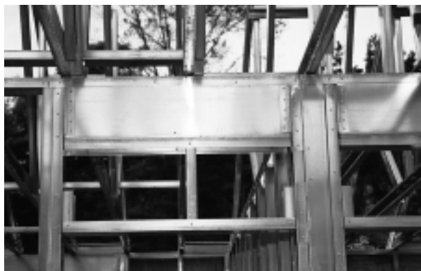
写真5 壁と梁の接合状況
