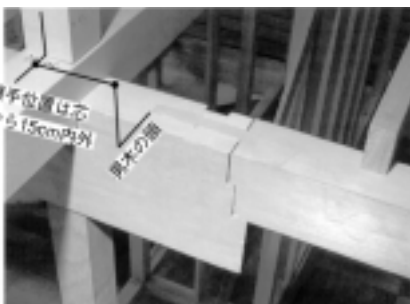
写真5 1/3縮尺構造模型（鎌継ぎの例）
