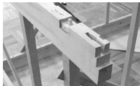
写真3 1/3 縮尺建築構造模型の仕口と継手
