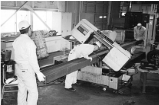
帯のご盤による柱・梁部材の切断
