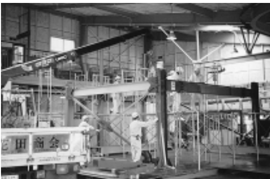
トラッククレーンによる大梁 - 小梁の建方施工
