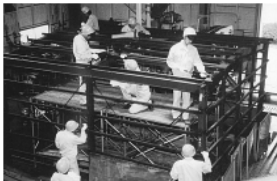
軽量鉄骨造の高力ボルト施工中
