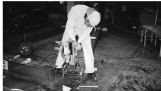
ドリルによるボルト孔加工
