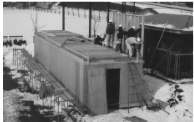
図6 2階壁建て起こし
