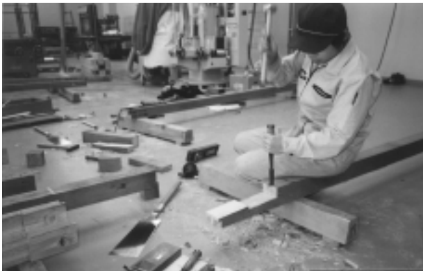
図4 土台継ぎ手加工
