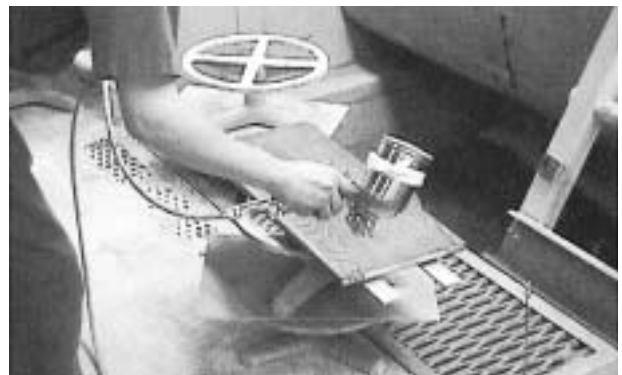
図4 スプレーガンによる吹き付け
