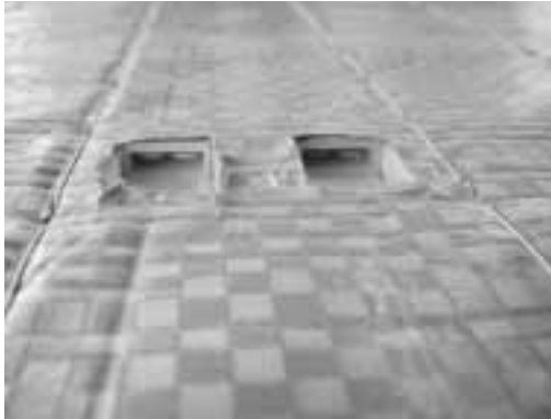
図9 電気配線コネクタ部
