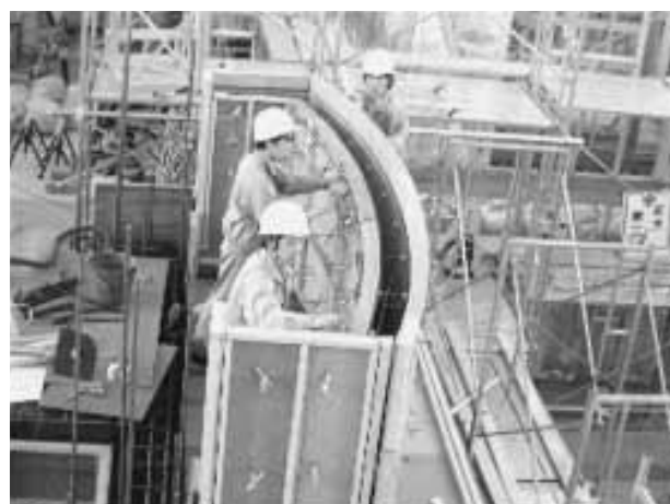
写真2 曲面壁バルコニーの実施施工
