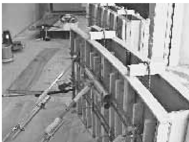
写真1 曲面壁のモックアップ
