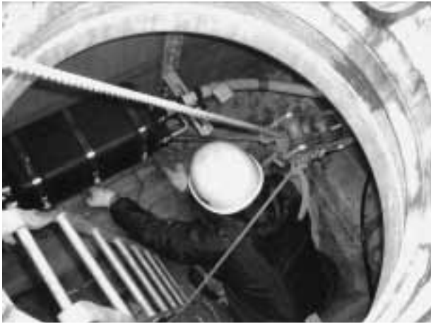
図7 地下光ファイバケーブル敷設現場
