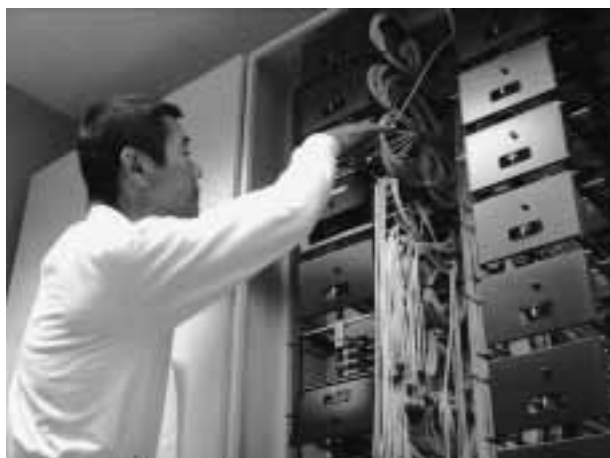
図6 光成端箱接続現場
