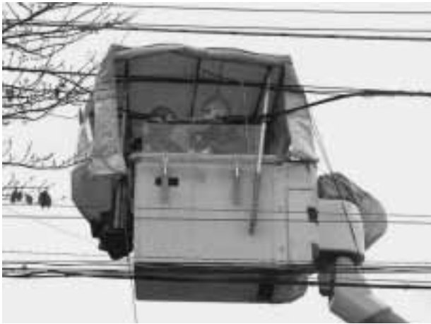
図8 架空光ファイバケーブル敷設現場
