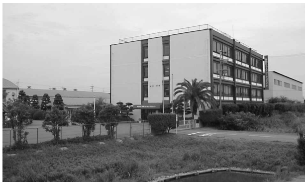
写真1 技術研修センター
