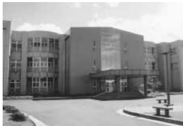
写真2 実験研究棟の外観
