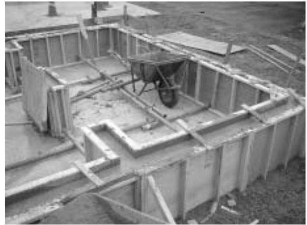
写真2 鉄筋型枠コンクリート打設
