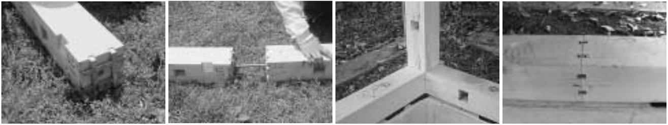
写真2 井桁継手およびしなり込み栓
