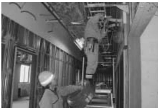
写真2 現場打ち合わせ中
