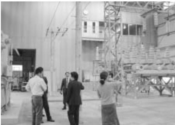
写真5 訓練用模擬変電所
