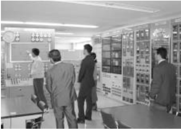
写真4 電力系統制御訓練設備
