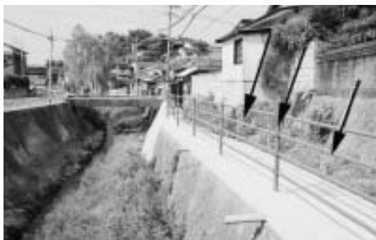
図9 舳石の位置（矢印により指示した箇所）
