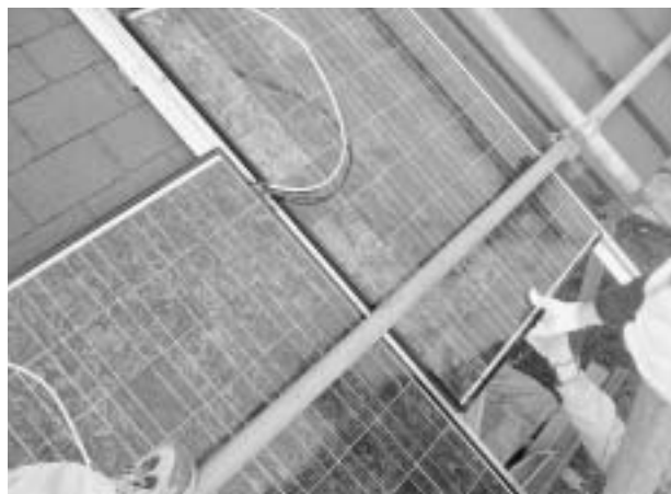
写真2 太陽光発電パネル取り付け
