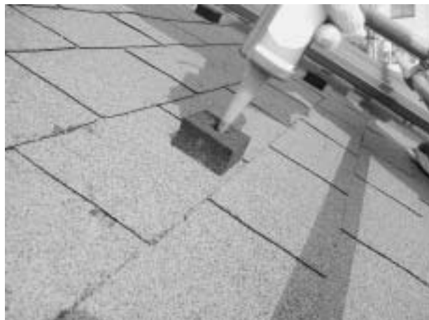
写真1 屋根防水処理シーリング
