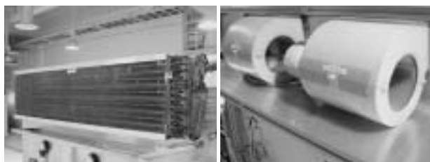
図7 蒸発器設置状況
