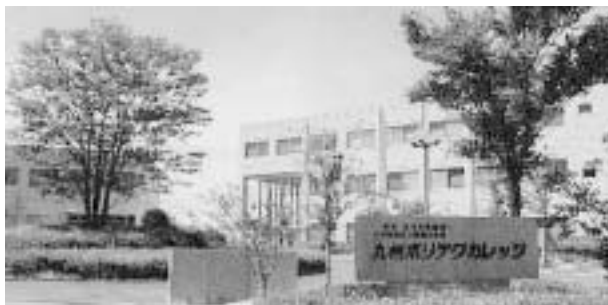
写真1 九州職業能力開発大学校
