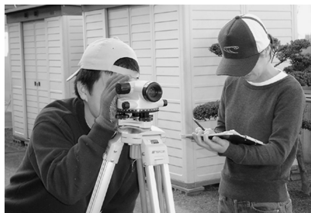
図7 「施工管理技術」建築測量実習
