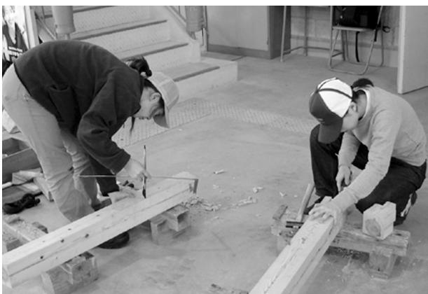
図2 「基本実習」継手・仕口加工
