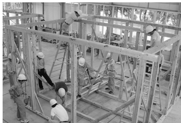
図3 「躯体施工」模擬家屋施工実習
