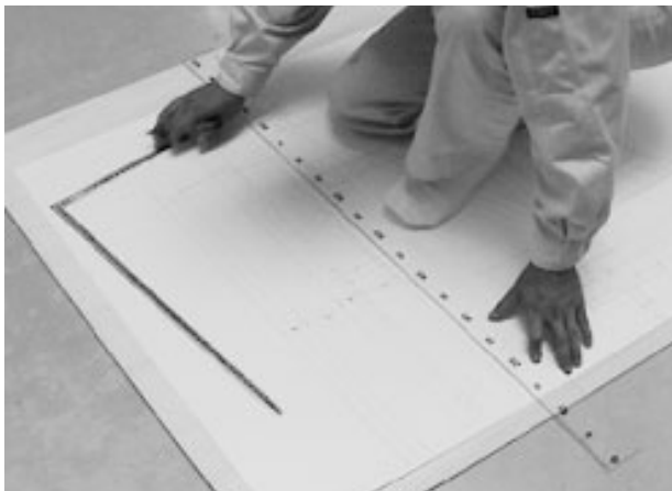
図6 現寸図(振たる木展開図の書き方)画像
