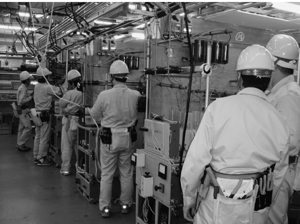
写真2 高圧受電設備施工実習風景
