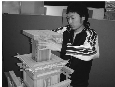
図3 心柱を納めている状況
