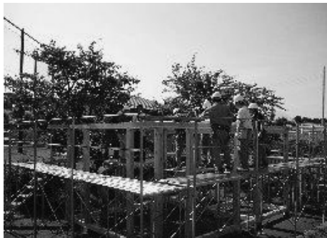
施工実習（木造組立）
