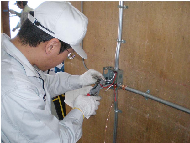
写真1 一般電気工事の様子
