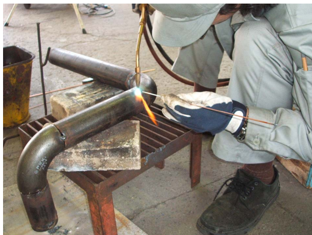
写真3 溶接作業の様子
