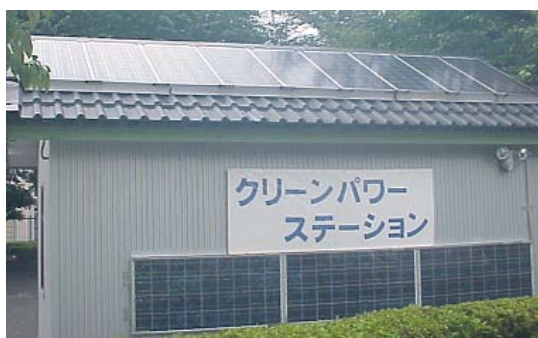
図8 職業大東京校での敷設状況
