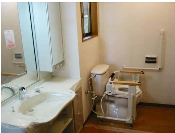
写真1 福祉用洗面台、トイレ施工
