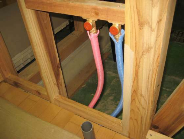
写真5 ミニキッチン 配管施工
