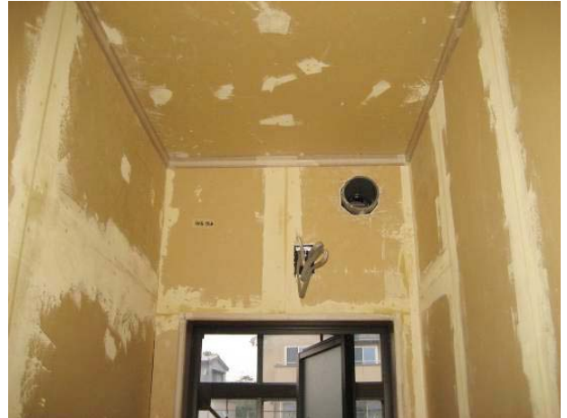
写真8 内装 石膏ボード
