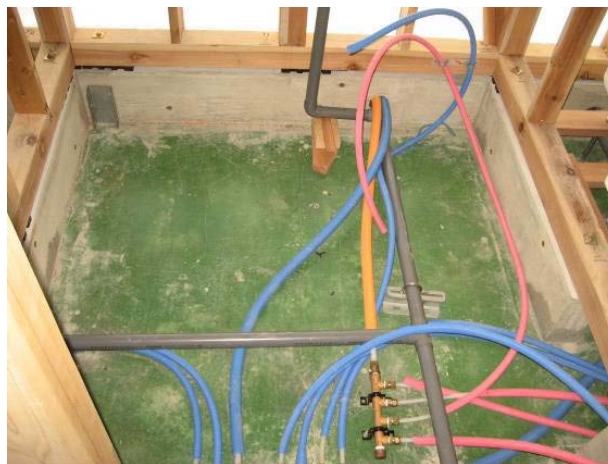
写真4 洗面所床下配管施工
