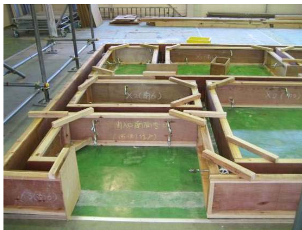
写真3 基礎型枠（20年度）
