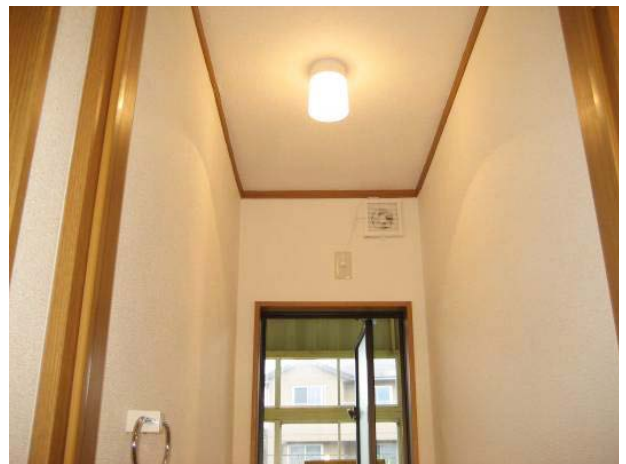
写真10 照明器具換気扇取付
