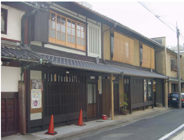
図3 大正時代の町屋 修復と耐震改修
