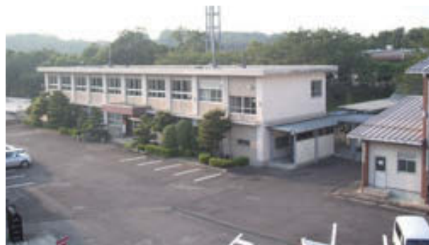
図1 職業能力開発校本館
