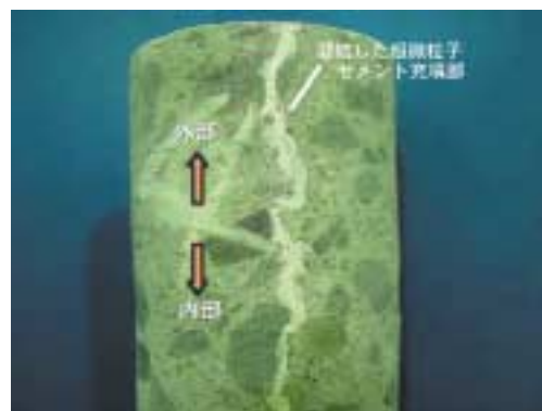
技術開発 超微粒子セメントによるひび割れ補修 (コア抜き後)
