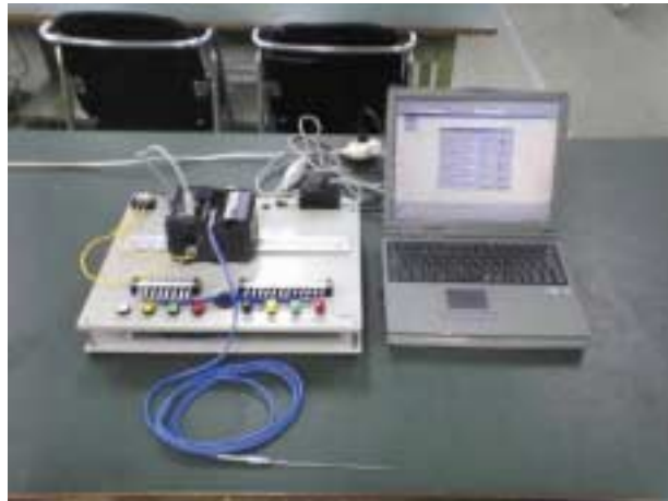
図1 PLCとパソコン
