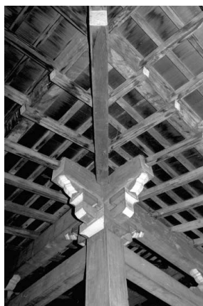
図9 旧岡崎邸能舞台目付柱の柱頭と軒裏
