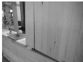
写真9 TB - 2梁材の割裂
