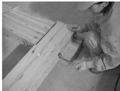
写真19 六角ボルト挿入
