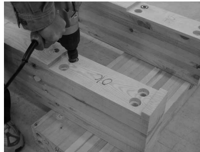
写真17 柱の接合具挿入
