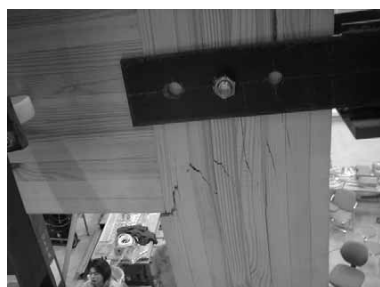
写真14 載荷側柱の引張割裂破壊
