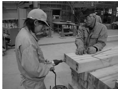
写真18 梁の接合具挿入
