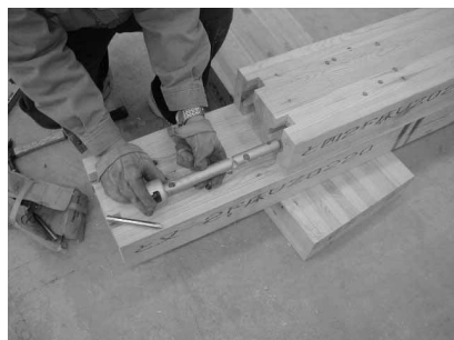
写真21 柱脚金物挿入
