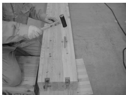
写真22 ドリフトピン打ち込み
