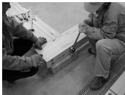
写真20 六角ボルト締付け
