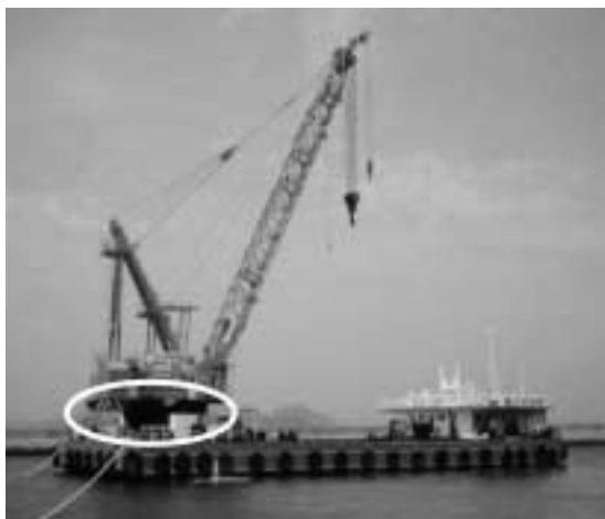
図1 洋上クレーン
