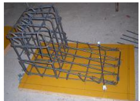
図1 鉄筋配筋製作
