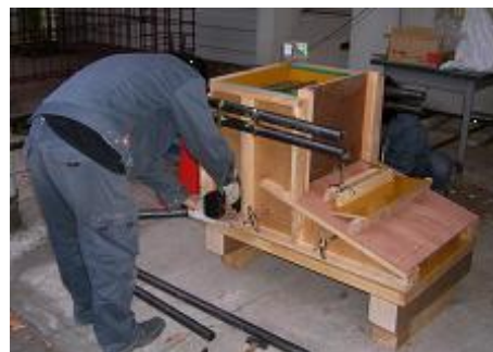
図 2 型枠製作
