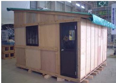
図1 シェルター完成
