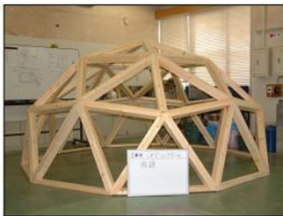
写真1 ドーム枠組み
