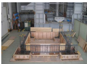
写真1 基礎梁躯体工程写真
