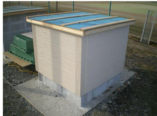
写真 2-2 模擬実験棟 (木造)
