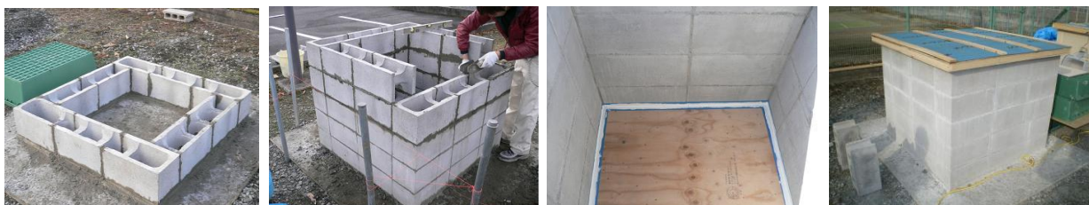
①基礎部分の施工 → ②ブロックの組積 → ③内部の目地処理 → ④RM造の完成
