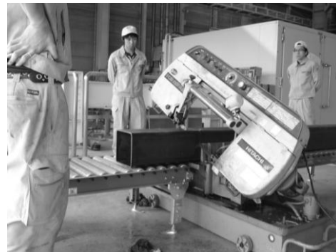
写真1 鋼材の切断状況
