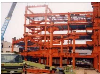
写真2 鉄骨建て方の工事写真
