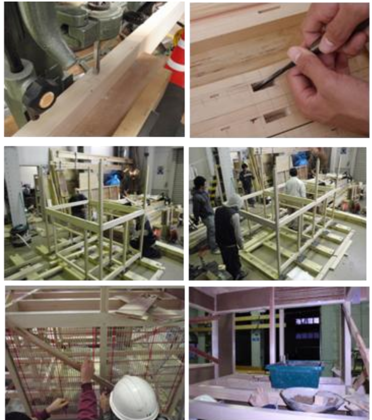
写真2 模型軸組みの組み立てと土壁の施工
