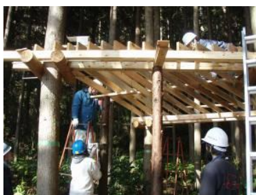
図5 根太取付け
