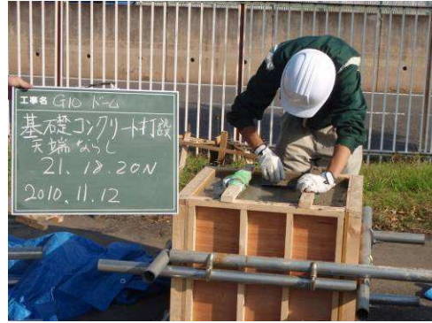
図7 基礎コンクリート打設
