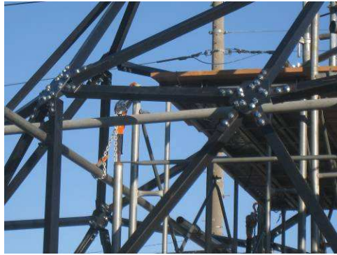
図 12 足場から吊り下げた支保工
