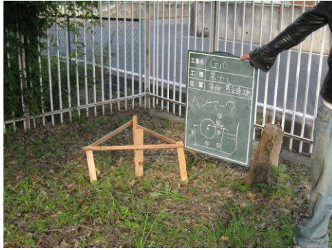
図6 ベンチマーク設置
