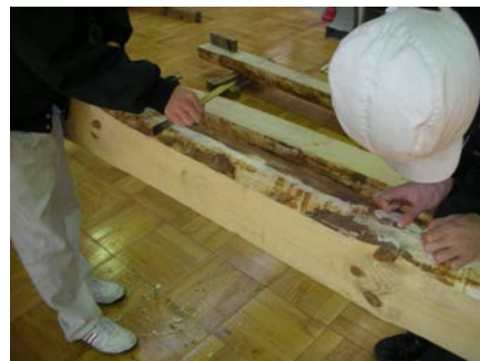
図2 心墨打ちの様子
