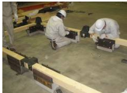
図21 共通基礎システムと土台設置施工
