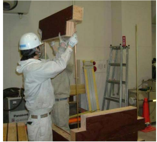
図1 3 施工手順 (木質ブロック組積)
