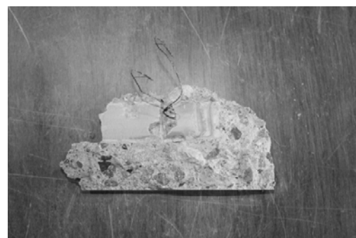
図5 コンクリート破片
