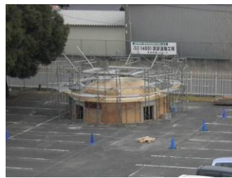
写真4 型枠組立完了
