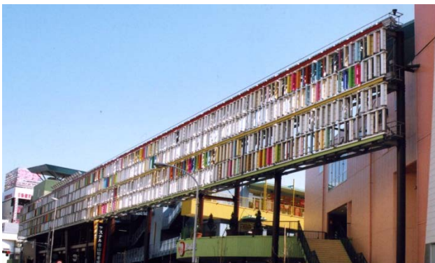
図7 金山駅前に設置されたサボニウス型風車
