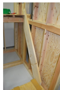
写真 4 側げた取付け
