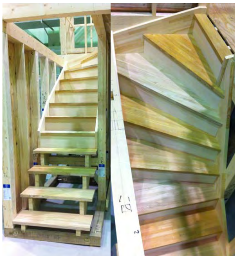
写真2 完成した階段
